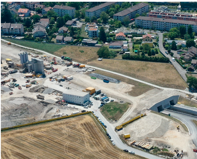
Installations de chantier à Pré-du-Stand (juillet 2022)
