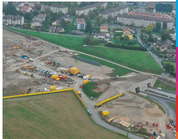
Remblayage de la parcelle de Pré-du-Stand (octobre 2022)
